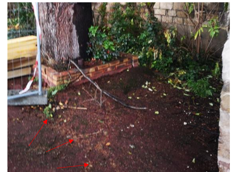
Figure 26 – Racines étendues et proches du mur de soutènement, végétation dense et invasive proche du mur arrière
