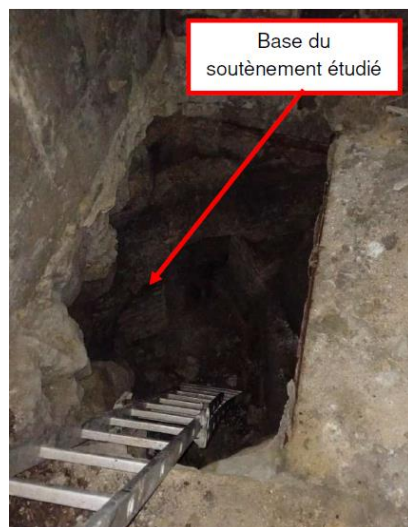
Figures 38 – Base du mur de soutènement observé au niveau de l'accès vers le niveau N-2
