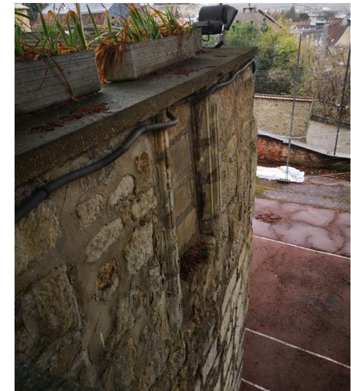
Figure 11 – Ancienne baie comblée et tronquée sur le mur latéral
