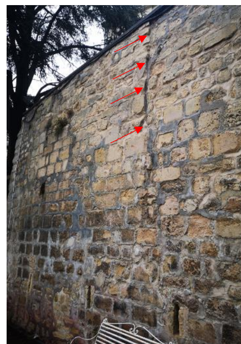
Figure 13 – Ancien chaînage de pierre, formant une légère saillie et un défaut de harpage (limite constructive ?)
