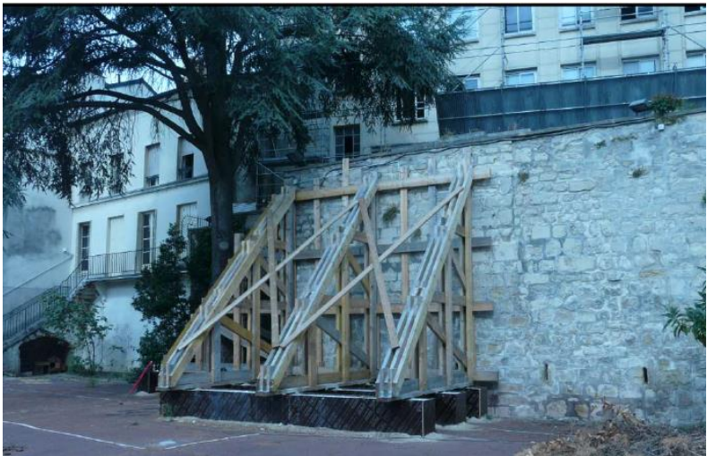
Figures 41 –Etaieement du mur de soutènement
