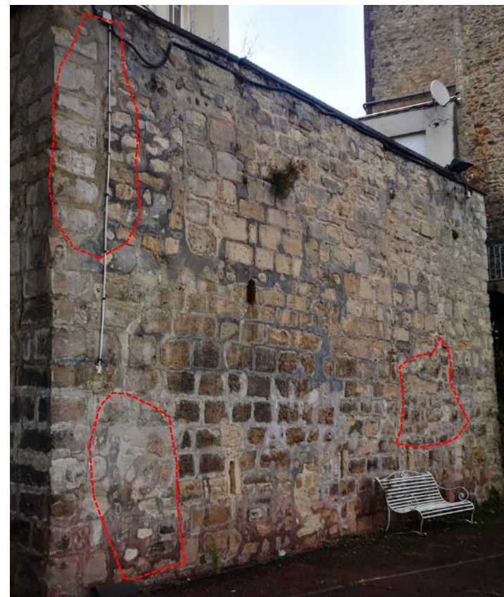
Figure 9 – Irrégularités de l'appareillage de la maçonnerie (mur de face), des reprises au ciment sont visibles
