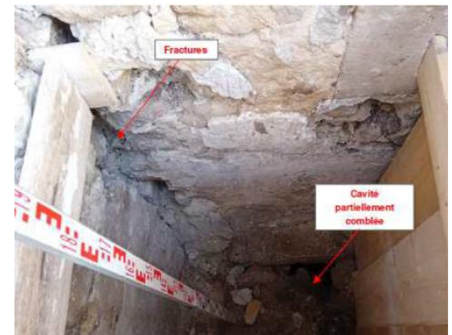
Figure 20 – Lézarde traversante et lessivage de la maçonnerie
