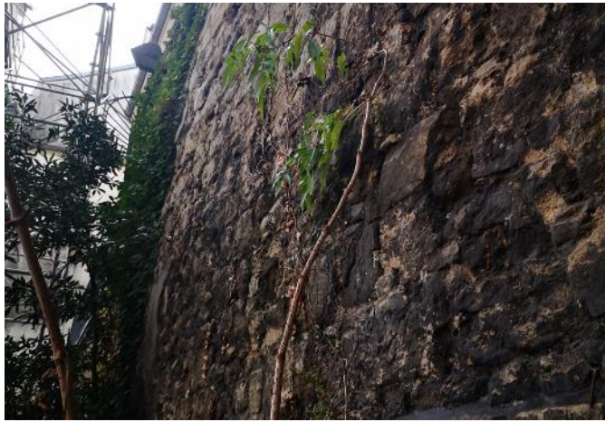
Figure 28 – Végétation grimpante sur le mur arrière, les pierres ont une teinte noircie
