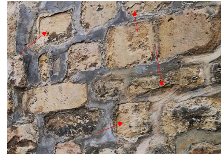
Figure 25 – Desquamation et pulvérulence de la pierre (mur de face)
