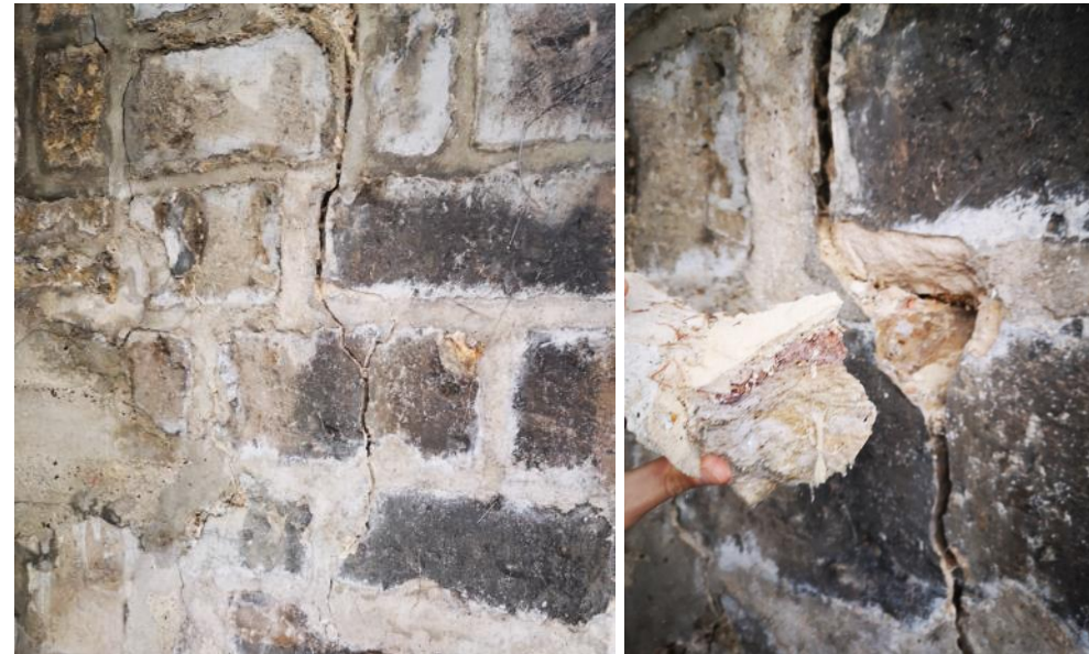
Figure 23 – Fracture de la pierre (mur latéral)
