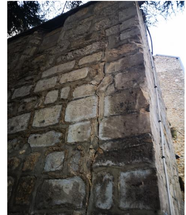
Figure 19 – Lézarde traversante du mur
